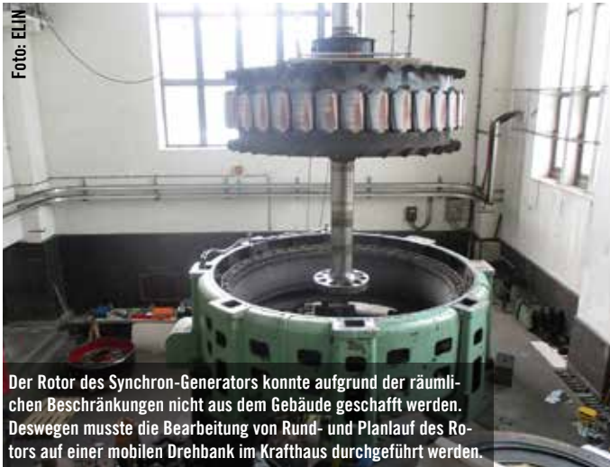
Demontage des rund 50 t schweren Generator-Armsterns.
